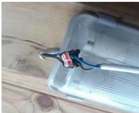
**Description :** L'installation électrique comporte au moins une CONNEXION avec une partie active nue sous tension accessible.
