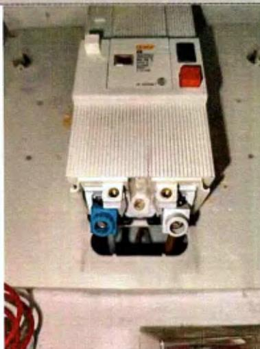
Description : A l'intérieur du tableau, la section d'au moins un conducteur alimentant les dispositifs de protection n'est pas adaptée au courant de réglage du disjoncteur de branchement.
