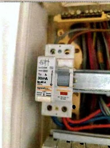
Description : Le courant assigné de l'INTERRUPTEUR différentiel placé en aval du DISJONCTEUR de branchement n'est pas adapté.
