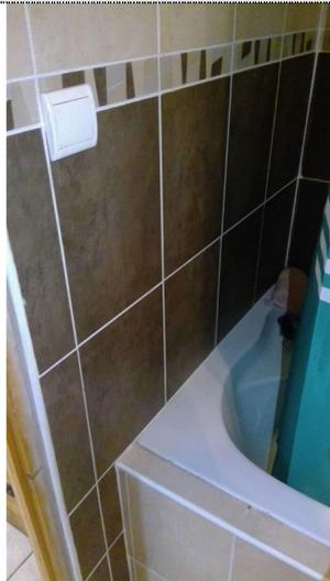
**Description :** Local contenant une baignoire ou une douche : l'installation électrique ne répond pas aux prescriptions particulières appliquées à ce local (adéquation entre l'emplacement où est installé le MATERIEL ELECTRIQUE et les caractéristiques de ce dernier – respect des règles de protection contre les chocs électriques liées aux zones).
