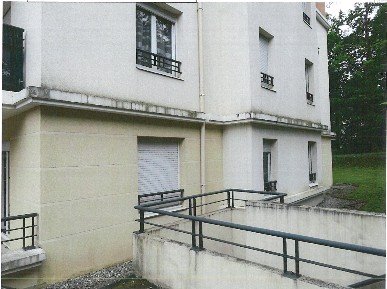
Photos n° 3 – 4 : PARTIES EXTERIEURES
