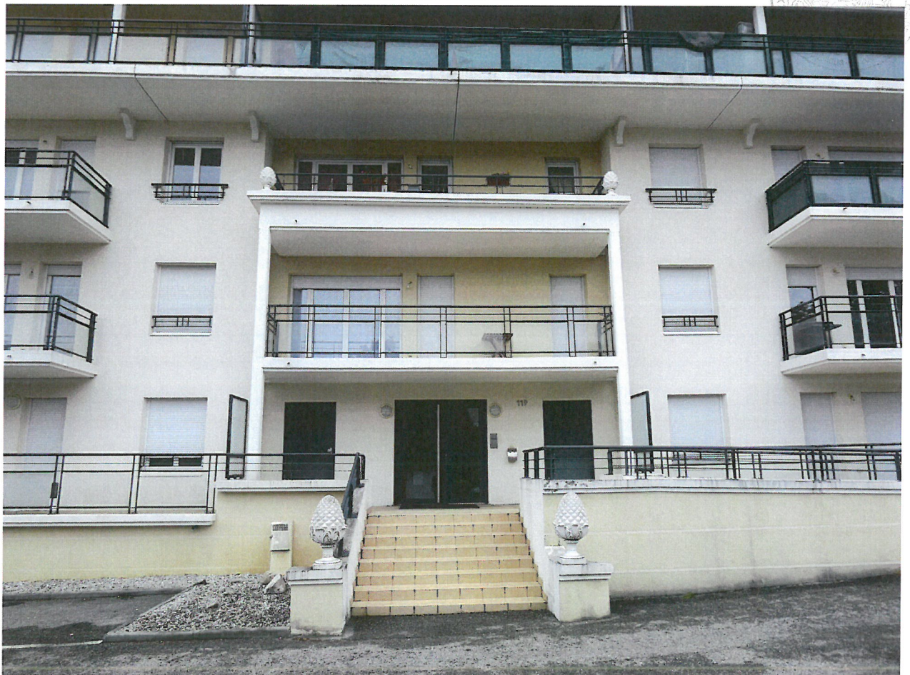
Photos n° 1 – 2 : PARTIES EXTERIEURES
