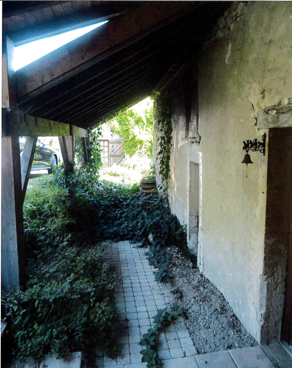
Photo n 3 : PARTIES EXTERIEURES ; FACADE COTE RUE DE MONTVERNIER ORIENTATION COTE OUEST
