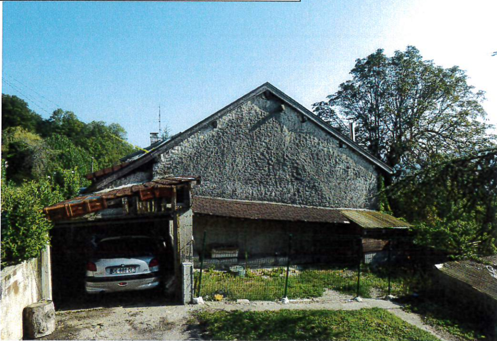
Photo n° 4 : PARTIES EXTERIEURES ; FACADE SUD
