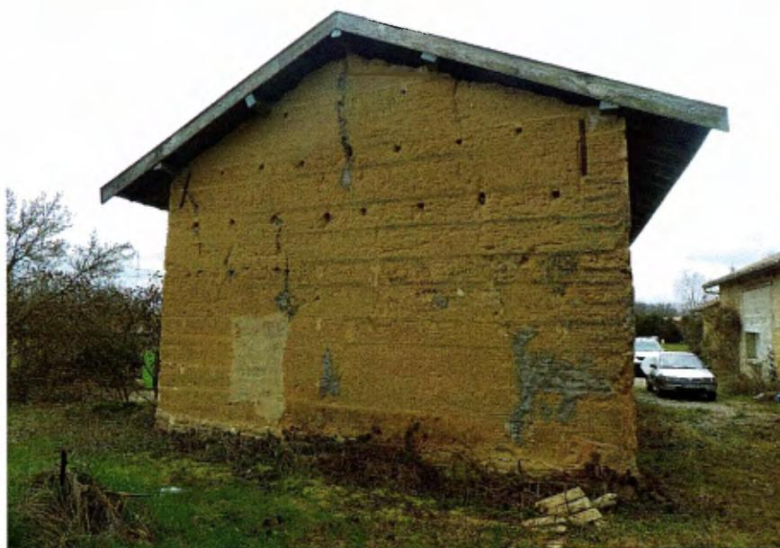
Sur le dessus est positionnée une couverture, composée d'une charpente de bois, soutenant un ensemble de lignes de tuiles plates mécaniques de terre cuite.
