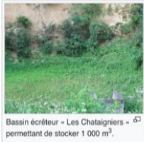
Bassin écrêteur « Les Châtaigniers » 62 permettant de stocker 1 000 m 3 .
