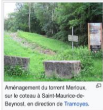
Aménagement du torrent Merloux, sur le coteau à Saint-Maurice-de-Beynost, en direction de Tramoyes. 63
