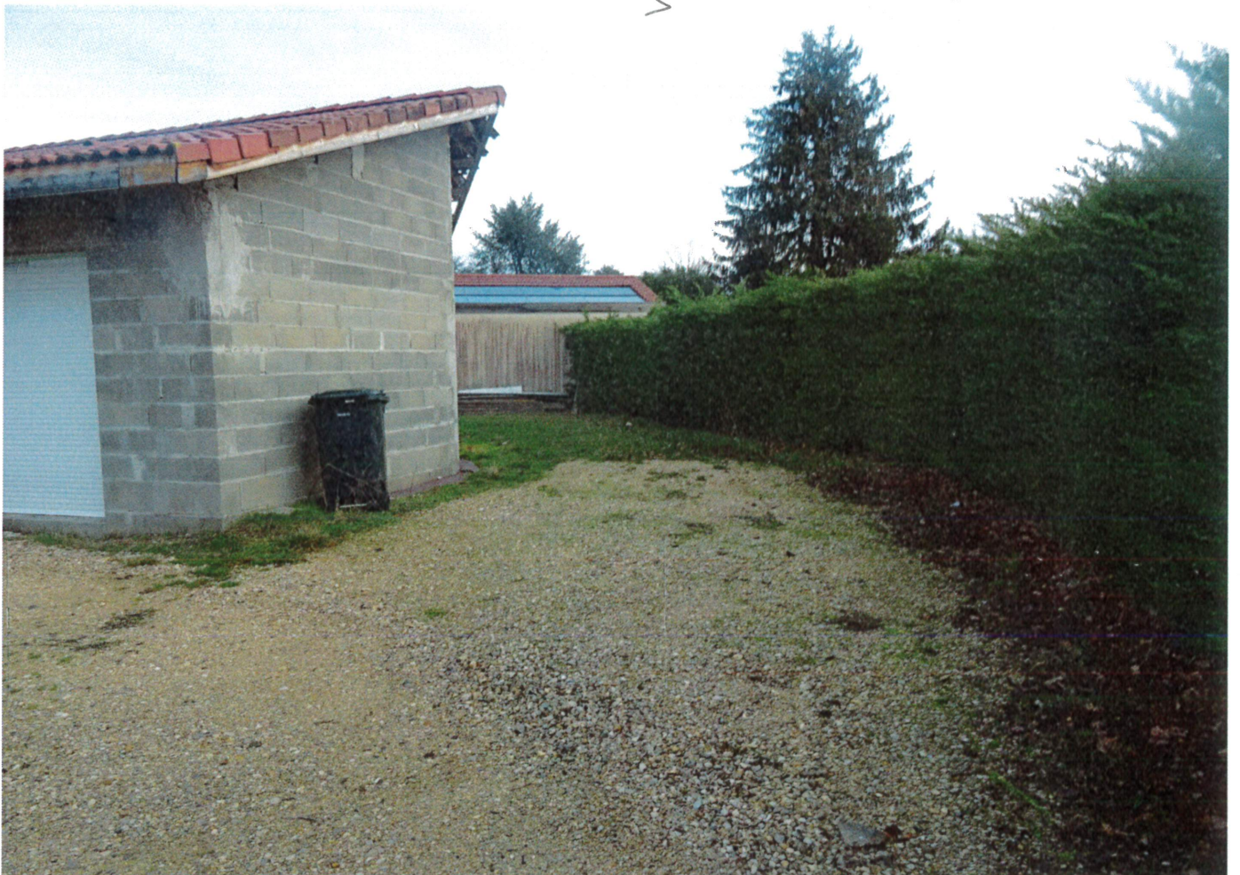
Facade Nord Exterior
