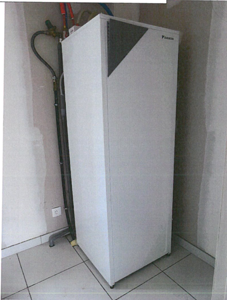
Photos n° 26 – 27 : PARTIES INTERIEURES ; CELLIER
