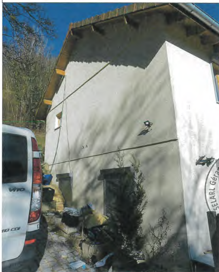
Photos n° 40 – 41 – 42 : PARTIES EXTERIEURES ; FACADE OUEST
