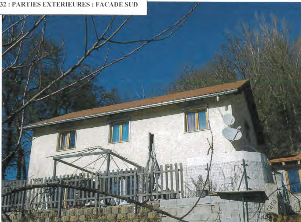
Photos n° 31 – 32 : PARTIES EXTERIEURES ; FACADE SUD
